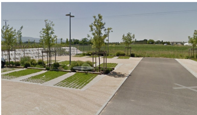
Figure 3 Exemple -Parking dalle béton alvéolé
